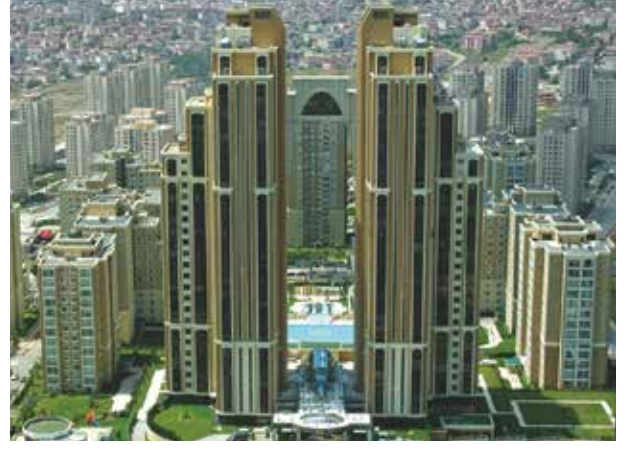
Proje İsmi : Uphill Court Towers Şehir : İstanbul Yatırımcı : Teknik Yapı & Varyap Tarih : 2009
