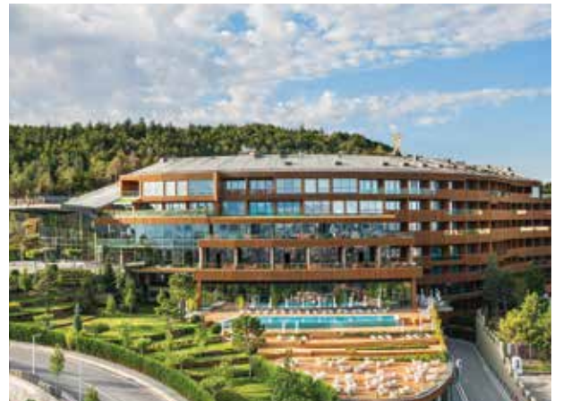
Proje İsmi : Rixos Thermal Otel Şehir : Eskişehir Yatırımcı : Polimeks İnşaat Tarih : 2013
