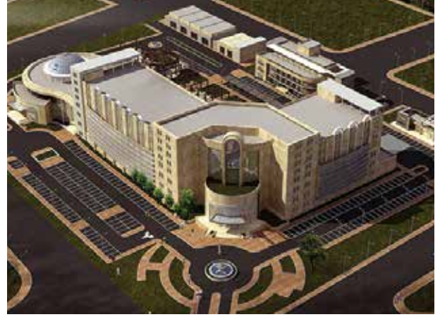
Proje İsmi : Rania 290 Yataklı Devlet Hastanesi Şehir : Süleymaniye, Kuzey Irak Yatırımcı : Kur İnşaat, İntaş İnşaat, Miran İnşaat Tarih : 2015
