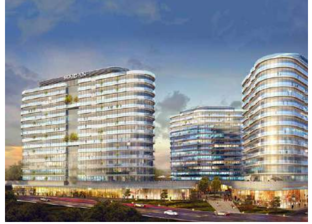
Proje İsmi : Maidan Residence Şehir : Ankara Yatırımcı : Ege Grup Yapı Endüstrisi A.Ş. ve BM Mühendislik ve İnşaat A.Ş. Tarih : 2016
