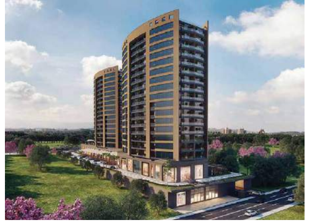
Proje İsmi : Ataköy Towers Şehir : İstanbul Yatırımcı : Aziz Yapı Tarih : 2016
