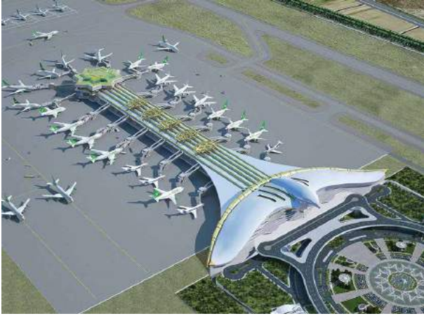
Proje İsmi : Aşgabat Havalimanı Şehir : Aşgabat, Türkmenistan Yatırımcı : Türkmenistan Ulaştırma Bakanlığı Tarih : 2014
