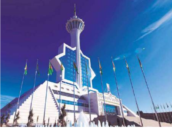
Proje İsmi : Tv Tower Şehir : Aşgabat, Türkmenistan Yatırımcı : Polimeks İnşaat Tarih : 2011
