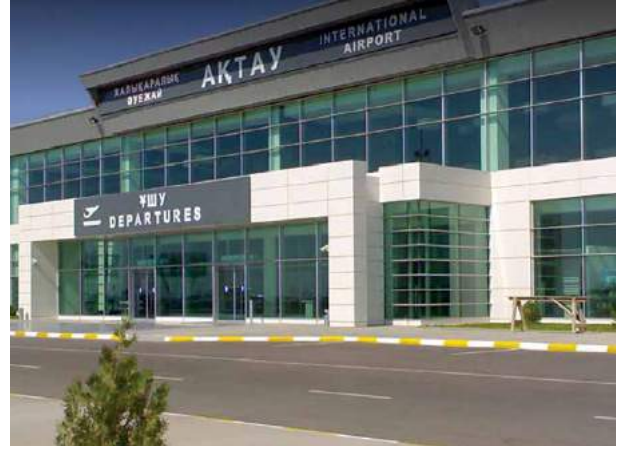
Proje İsmi : Aktay Havalimanı Şehir : Aktau, Kazakistan Yatırımcı : YDA İnşaat Tarih : 2012
